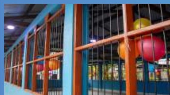
Ventanales Local Comunal Barrio Bajo - Bretaña
