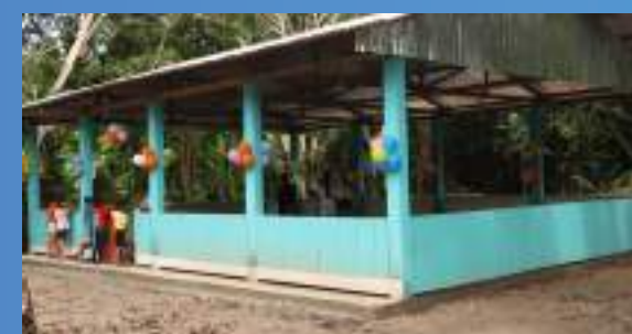
Construcción Local Comunal San José
