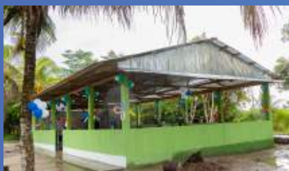
Construcción Local Comunal CN Las Palmas
