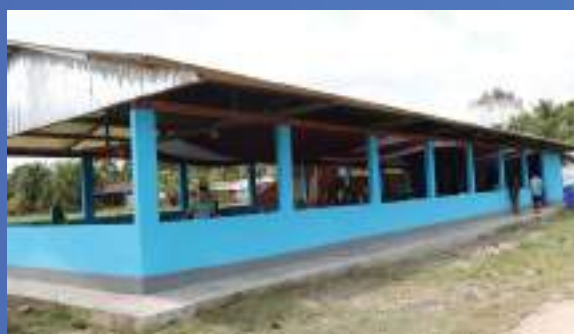
Refacción Local Comunal CP San Carlos
